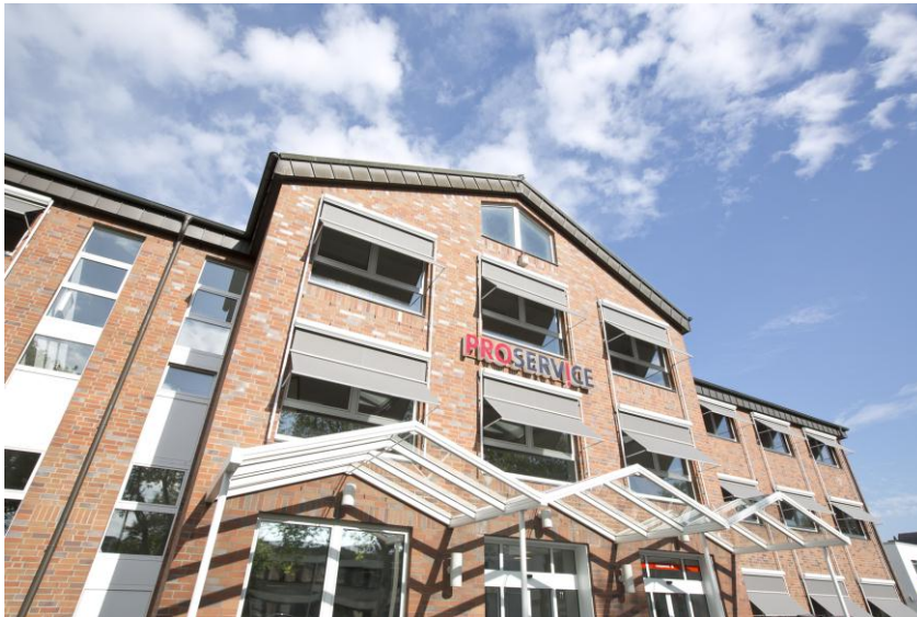
Abb.: Die neue PROSERVICE-Zentrale in der Einsteinstraße 11 in Sankt Augustin
